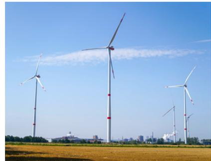
166 Meter beträgt die Nabenhöhe der sieben Windkraftanlagen. Vom Boden zur Flügelspitze sind es 237 Meter. Die Anlagen Vestas V136 sind auf dem neuesten Stand der Technik.
